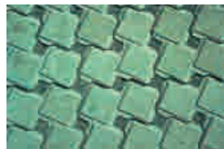
Abbildung 7: Verfüllung von Sickeröffnungen mit wasserdurchlässigem Splitt.
